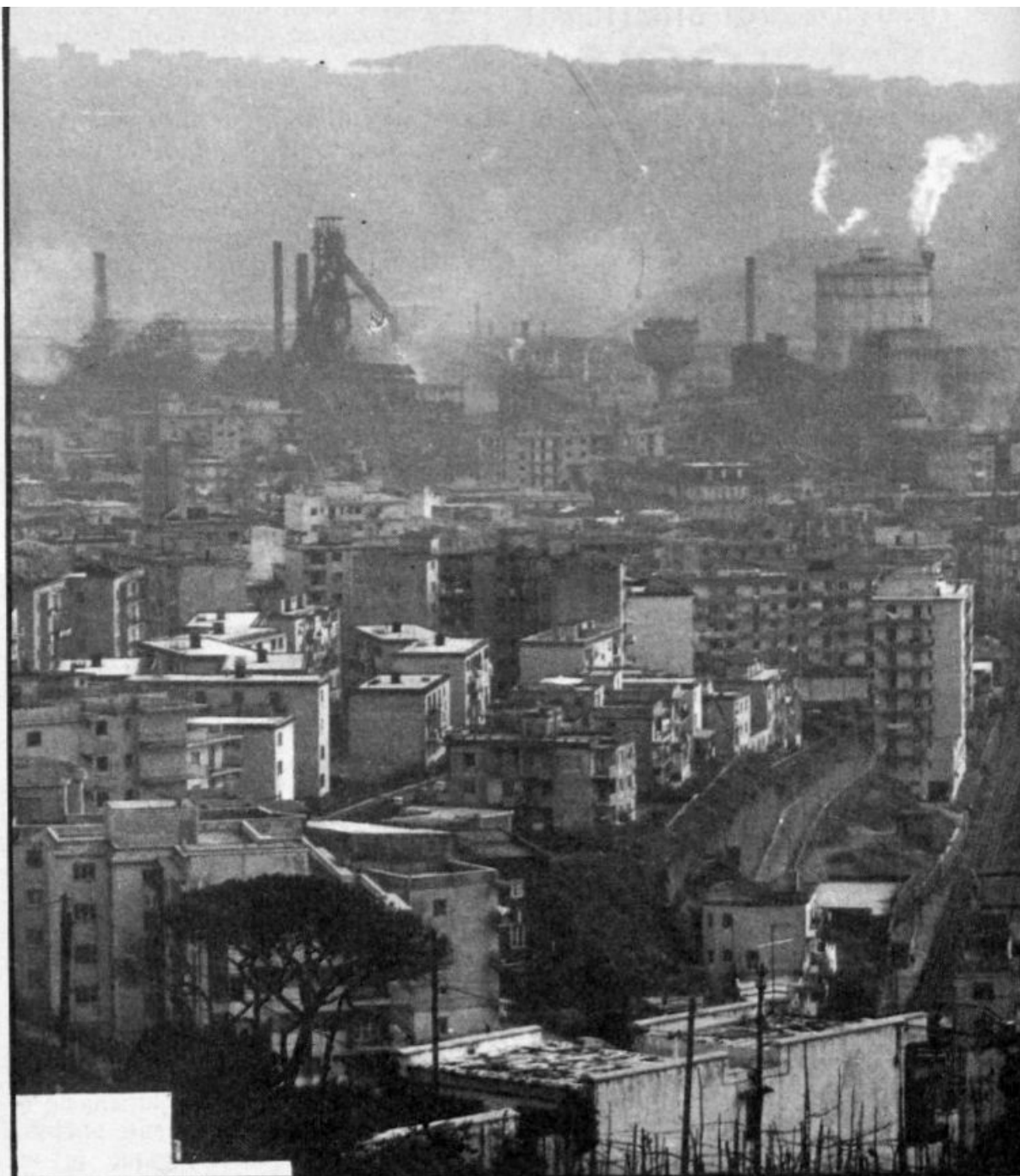
Napoli: gli stabilimenti dell'Italsider
