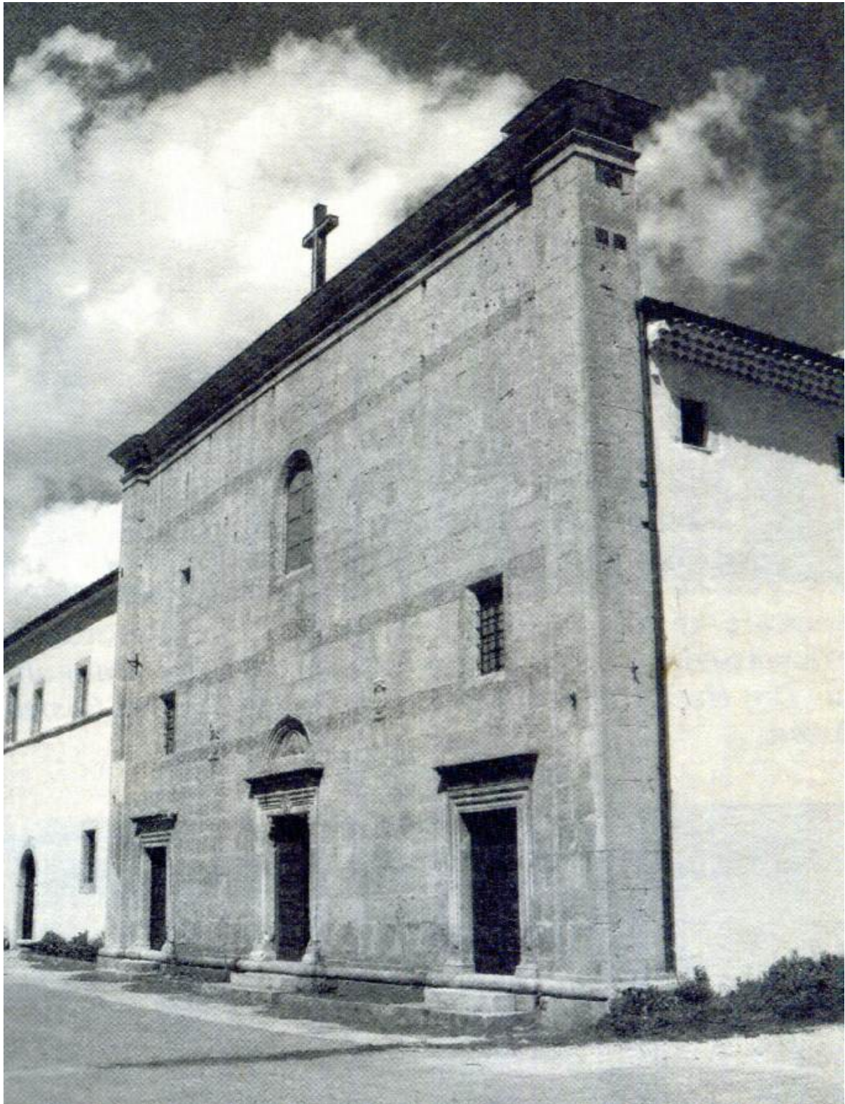
Il convento-santuario di Santa Maria di Stignano a San Marco in Lamis. Innalzato a partire dai primi anni del Cinquecento, venne completato nelle linee essenziali nell'ultimo quarto dello stesso secolo. La facciata della chiesa, caratterizzata da filari di conci di pietra rossiccia, ha nel motivo del portale rinascimentale il particolare di maggior pregio. I chiostrini sono due, circondati da colonnati.
