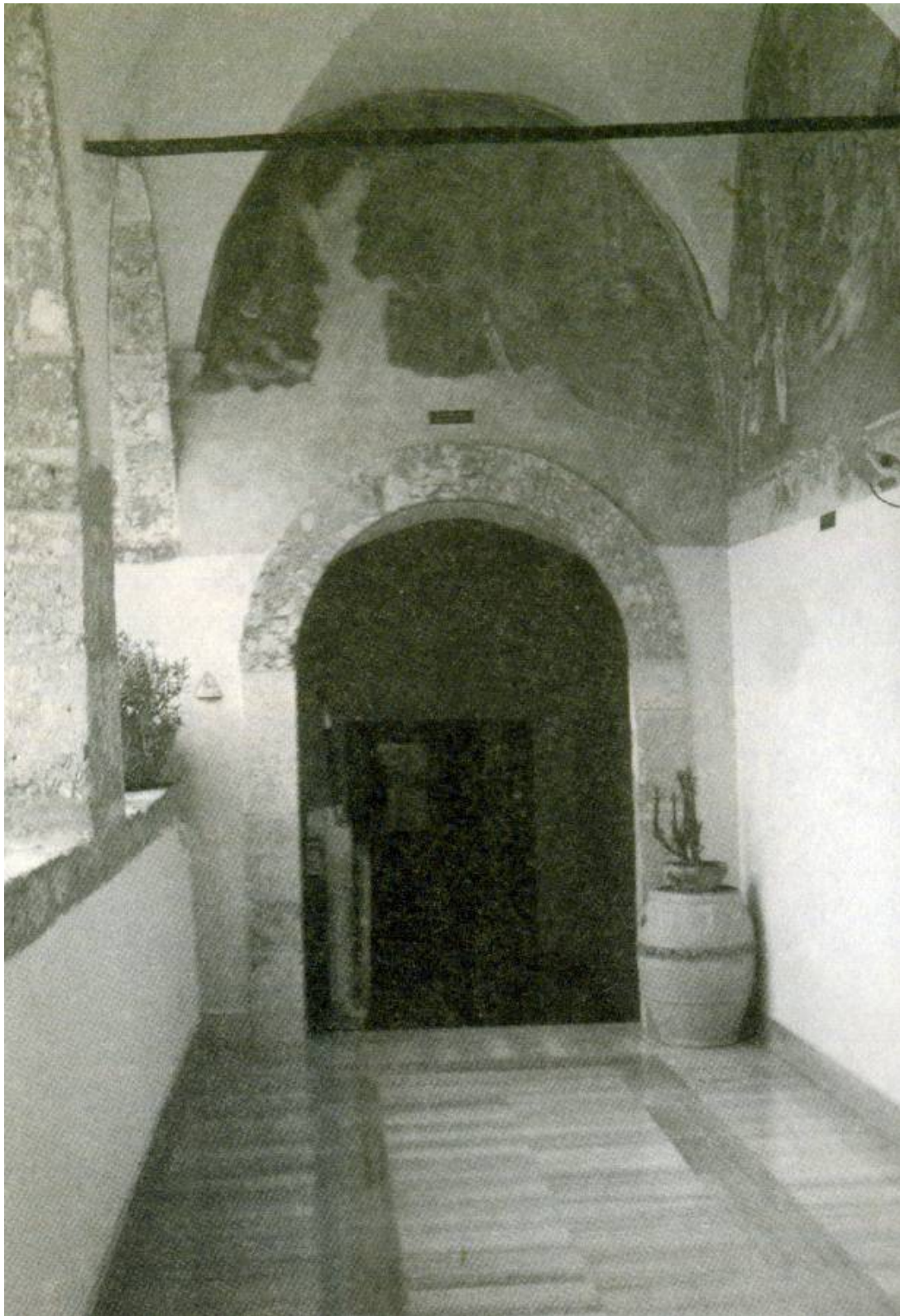
Ingresso all'auditorium del convento dal chiostro maggiore. Nel Cinquecento questo locale, che occupa l'area centrale del cenobio, aveva funzioni e dimensioni differenti rispetto all'odierna situazione. I porticati - in origine ininterrotto percorso che si sviluppava attorno ai due chiostri - concepiti per le esigenze pratiche legate alla natura religiosa dei francescani che accoglievano nei loro conventi i fedeli, fornivano anche riparo e ospitalità.
