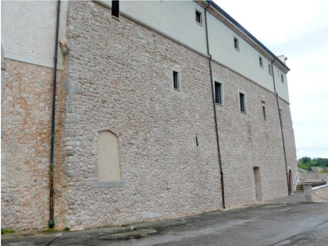
Parete settentrionale del Santuario di San Matteo. 129
