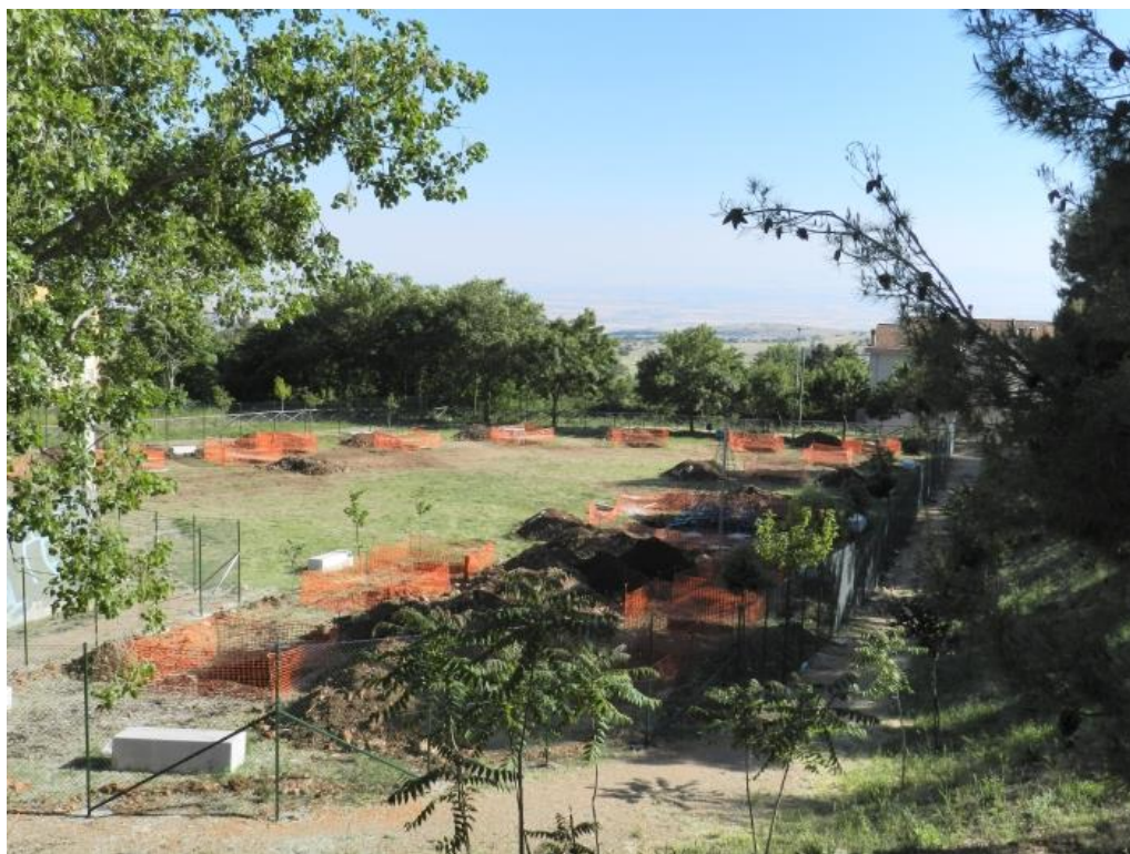
Il cantiere del Parco Avventura a Borgo Celano (San Marco in Lamis) – Foto scattata il 2 giugno 2014 in loco
